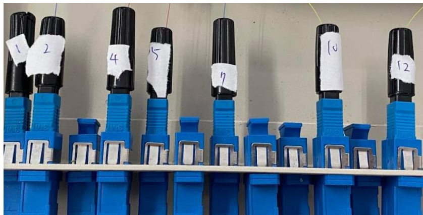
製作迅接頭並連接跳線讓鏈路能夠測通
