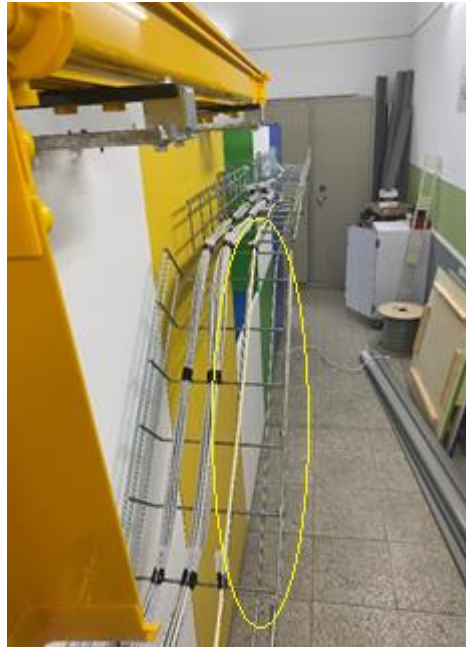
橋架上捆束整齊後用束帶固定在橋架上
