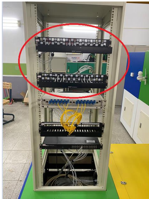
，再將 panel 鎖上機架和機櫃裡，並製作多條跳線連接，使鏈路能連通
